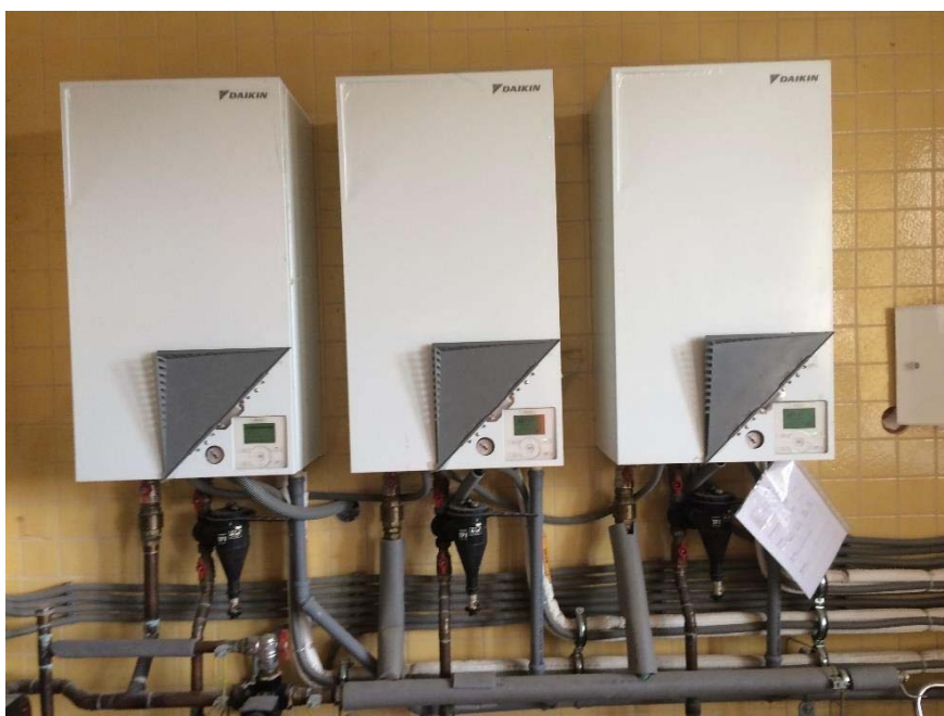
Obrázok 18: Vnútorné jednotky tepelných čerpadiel
