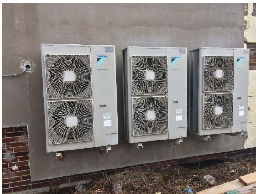
Obrázok 19: Vonkajšie jednotky tepelných čerpadiel
